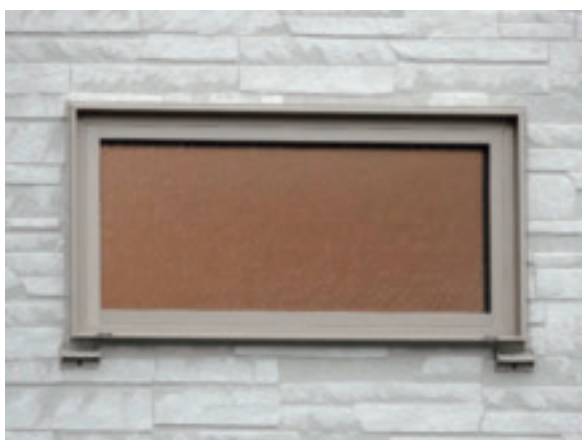
図 1-6-1 サッシ下に設置した伝い水防止水切り部材
