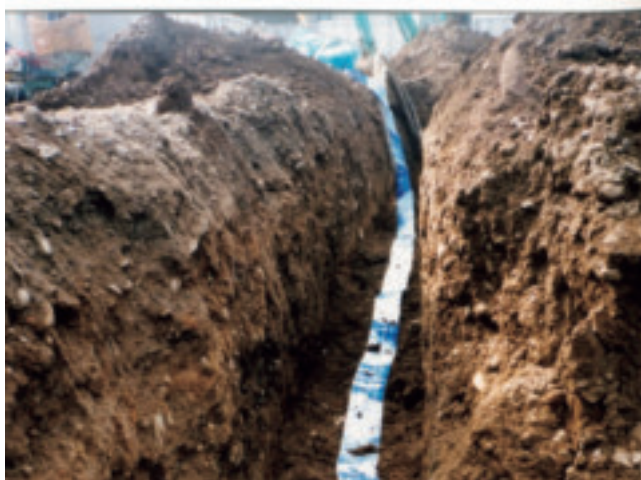
図3-1-2 地中埋設管の表示テープの施工例
