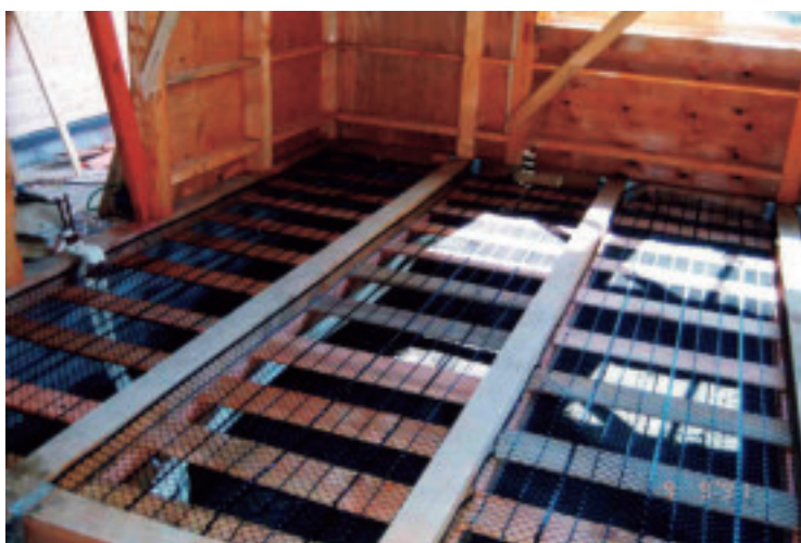
図資 7-5-4 床の断熱受材の施工例
