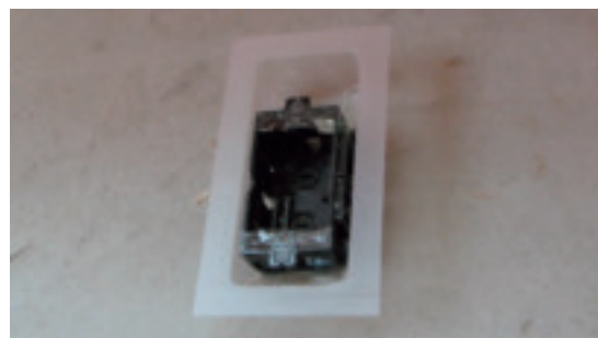
図資 7-5-23 気密コンセントボックスの例
